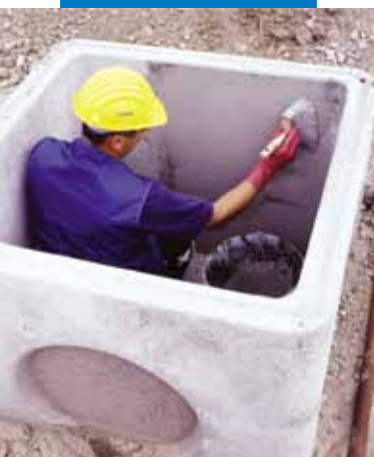
Στεγανωτική προστασία εφαρμοσμένη με θούρτσα σε ανθρωποθυρίδα από σκυρόδεμα
