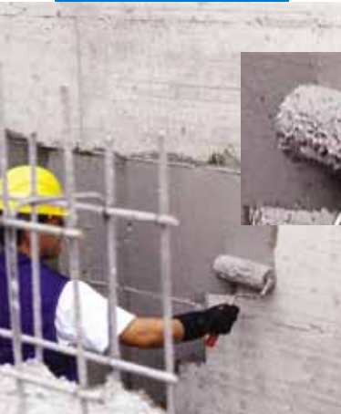
Στεγανωτική προστασία εφαρμοσμένη με ρολό σε τοίχιο θεμελίωσης
