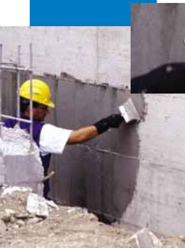
Στεγανωτική προστασία εφαρμοσμένη με θούρτσα σε τοίχιο θεμελίωσης
