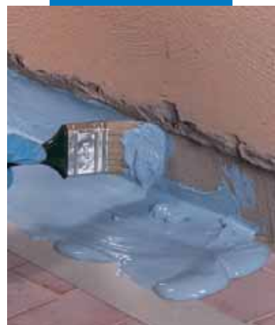
Εφαρμογή του Mapelastick® AquaDefense με βούρτσα σε αρμό μεταξύ δαπέδου-τοιχού, πριν την εφαρμογή του Mareband
