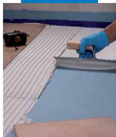
Τοποθέτηση πλακιδίων στην επιφάνεια του Mapelastick® AquaDefense
