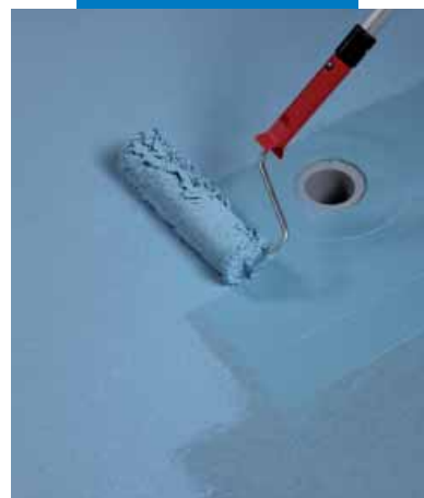
Εφαρμογή της δεύτερης στρώσης του Mapelastick® AquaDefense με ρολό
