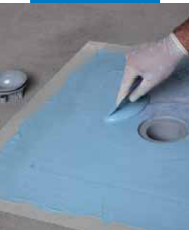
Εμποτισμός υφάσματος της σειράς Drain Vertical με Mapelastic® AquaDefense
