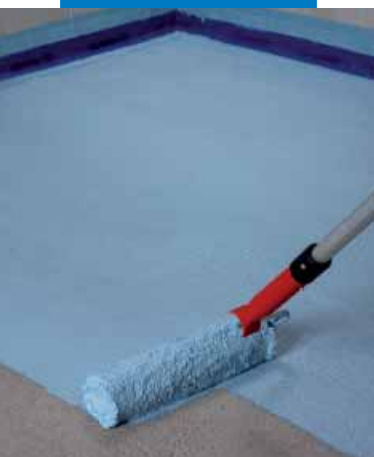
Εφαρμογή της πρώτης στρώσης του Mapelastic® AquaDefense σε τσιμεντοκονία δαπέδου
