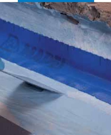
Τοποθέτηση Mapeband σε αρμό μεταξύ δαπέδου-τοιχίου με Mapelastic® AquaDefense
