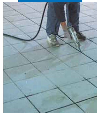
Σφράγιση αρμού διαστολής κεραμικών με Mapesil AC
