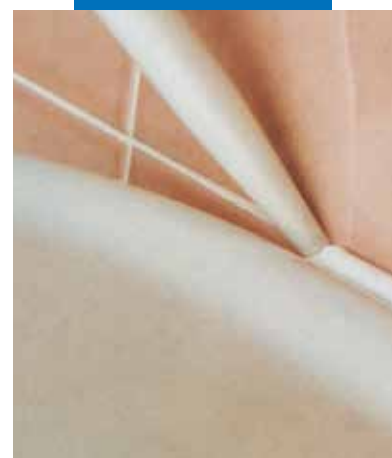
Σφράγιση ειδών υγιεινής
