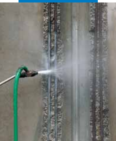
Καθαρισμός ράβδων οπλισμού
