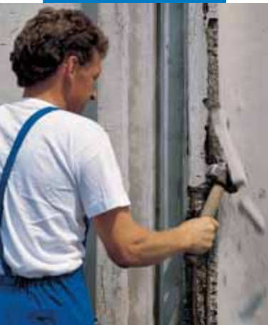
Αποξήλωση αποσπασμένου σκυροδέματος
