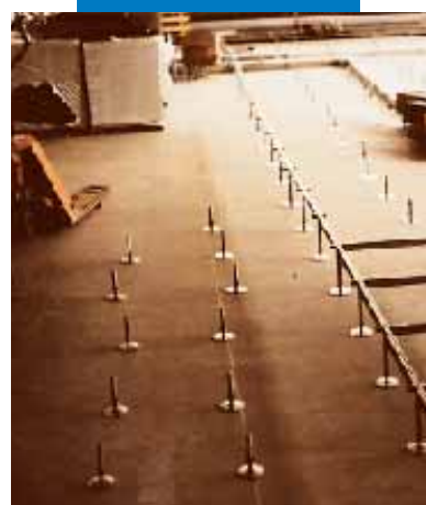
Πλάκα σκυροδέματος που έχει επιπεδωθεί με Ultraplan πάνω στην οποία θα τοποθετηθεί κολυμβητό δάπεδο
