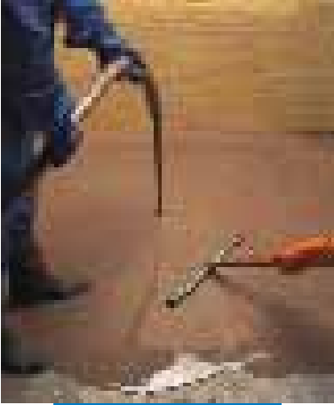
Εφαρμογή του Ultraplan με αντλία και λαστιχένια σκούπα
