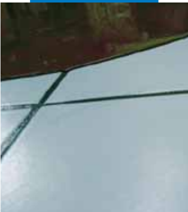
Λεπτομέρεια από την εφαρμογή του Ultraplan σε υπάρχον δάπεδο από κεραμικά πλακίδια μετά την εφαρμογή του Mapeprim SP
