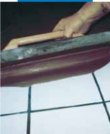
Εφαρμογή του Ultraplan με μεταλλική σπάτουλα σε υπάρχον δάπεδο κεραμικών πλακιδίων μετά την εφαρμογή του Mapeprim SP
