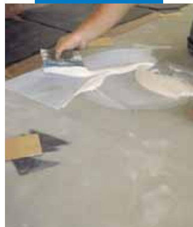
Παράδειγμα τοποθέτησης PVC σε επιφάνεια που έχει επιπεδωθεί με Ultraplan - CD2 - Μιλάνο - Ιταλία
