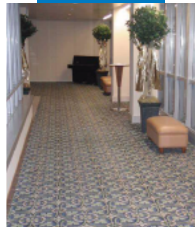
Τοποθετημένη μοκέτα σε διάδρομο ξενοδοχείου, μετά την επιπέδωση με Ultraplan Eco - Ξενοδοχείο Renaissance - Αυστρία
