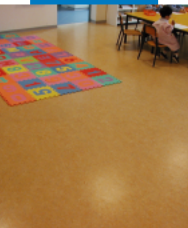
Τοποθετημένο linoleum σε τσιμεντοειδή δάπεδο που είχε προηγουμένως επιπεδωθεί με Ultraplan Eco - Νηπιαγωγείο Mirabello - Cantu (Como) - Ιταλία
