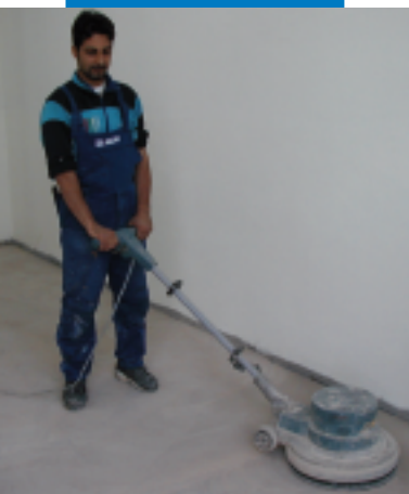
Λείανση με ελικοπτεράκι πριν την εφαρμογή Ultraplan Eco - Νηπιαγωγείο Mirabello - Cantu (Como) - Ιταλία
