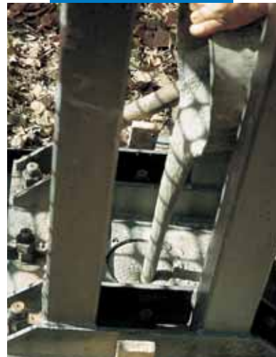
Αγκύρωση μεταλλικού σκελετού με Mapefill
