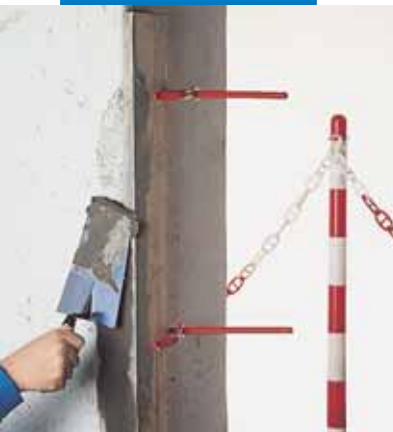
Αποκατάσταση κατακόρυφων γωνιών με Nivorapid
