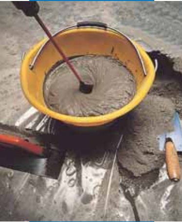
Ανάμειξη του Nivorapid με ηλεκτρικό αναμεικτήρα
