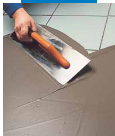
Επιπέδωση υπάρχοντος δαπέδου με Nivorapid
