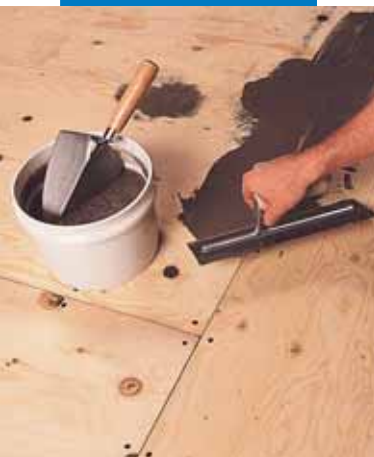
Αρμολόγηση υποστρώματος από κόντρα πλακέ με Nivorapid + Latex Plus
