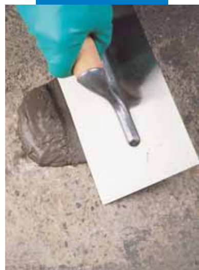
Αποκατάσταση οριζόντιων ανωμαλιών με Nivorapid
