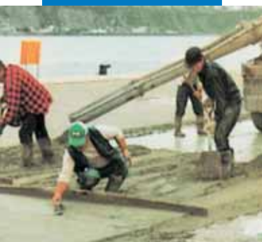
Εξωτερικό δάπεδο από σκυρόδεμα με πρόσμικτο Planicrete. Vieux Port, Κεμπέκ, Καναδάς
