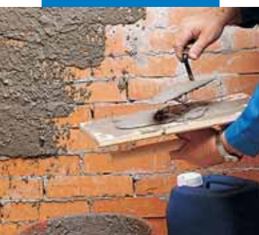
"Πεταχτή" στρώση σοβά ενισχυμένη με Planicrete
