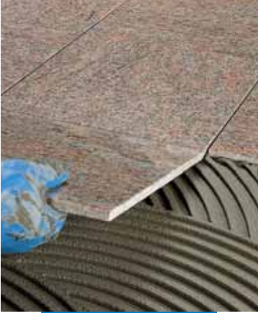
Τοποθέτηση προ-γαλισμένου μαρμάρου σε δάπεδα
