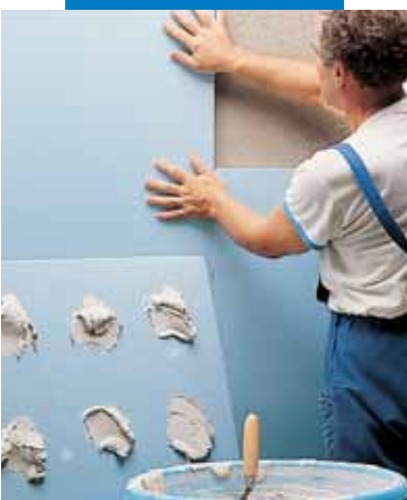
Τοποθέτηση φύλλων πολυστερίνης με λευκή Keraflex
