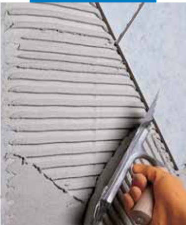
Τοποθέτηση μονόπυρου πλακιδίου σε τοίχο από διγκωμένο αφρώδες σκυρόδεμα
