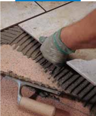
Μονόπυρο πλακίδιο σε τσιμεντόπλακα σε εξωτερικό τοίχο
