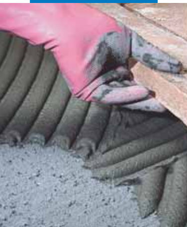
Εφαρμογή χειροποίητων πλακιδίων terracotta σε ανώμαλη επιφάνεια
