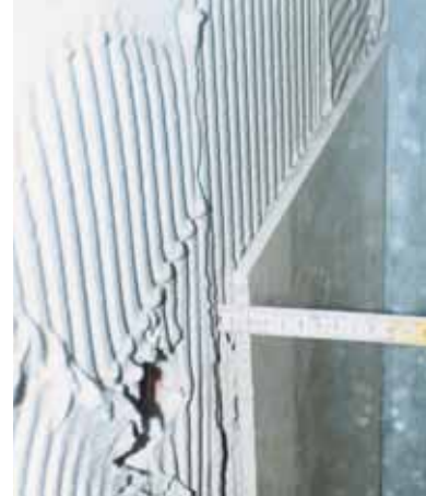
Τοποθέτηση πλακιδίων τεχνητού γρανίτη με μεγάλο πάχος κόλλας σε τοίχο
