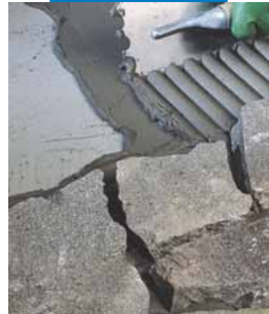
Τοποθέτηση πλακιδίων τεχνητού γρανίτη με μεγάλο πάχος κόλλας σε τοίχο
