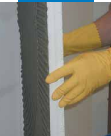
Τοποθέτηση του θερμομονωτικού πανέλου
