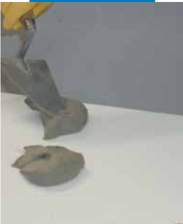
Εφαρμογή του Mapetherm AR1 στην πλάτη του μονωτικού φύλλου σημειακά με μυστρί
