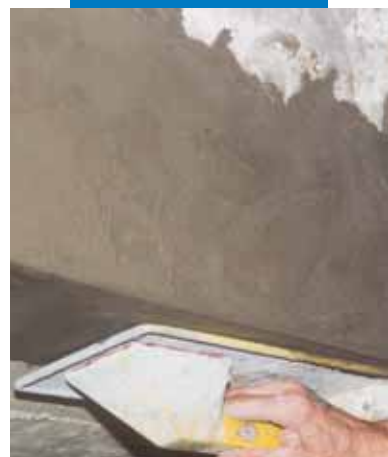
Τοπική επισκευή δοκού σκυροδέματος
