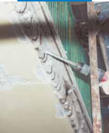
Αποκατάσταση της προστινής όψης της πλάκας σκυροδέματος ενός μπαλκονιού: προετοιμασία του υποστρώματος
